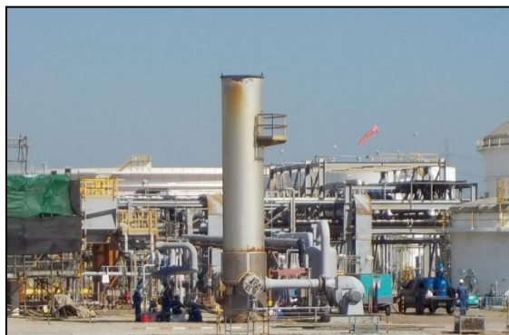
รูปที่ 3-19 ETP Ground Flare
