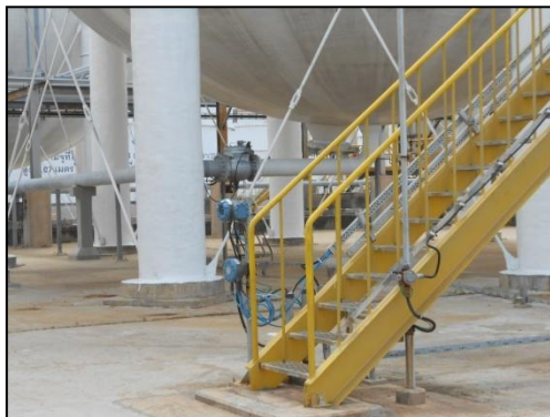
รูปที่ 3-42 Gas Detector
